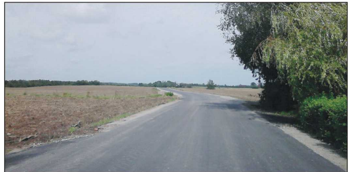
Droga w m. Kruszka po remoncie.
