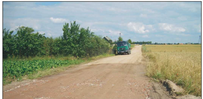
Droga w m. Kruszka przed remontem.
