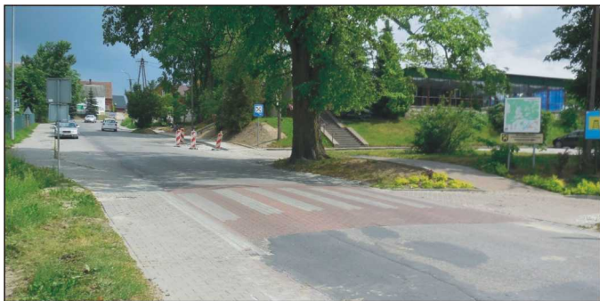
Chodnik wraz z wyniesionym przejściem przy ul. Cisowej.
