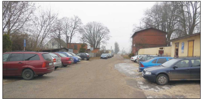
Ulica po remoncie.
